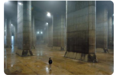
調正水橋 国土交通省 関東地方整備局ホームページより
